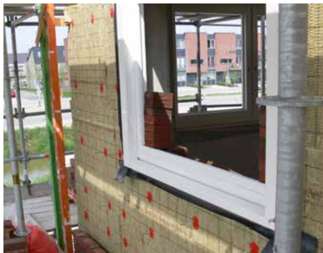
Ancrage pour façade avec UNI-CLIP
